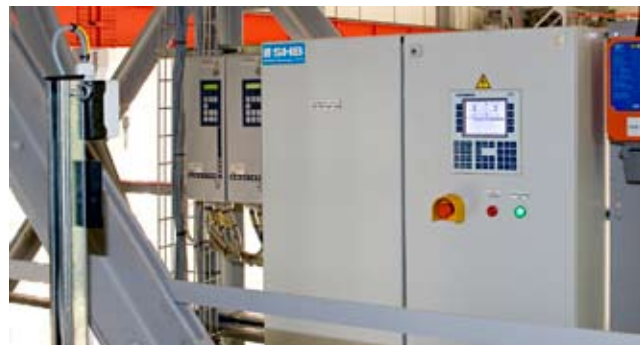
Emotrons elektroniska flänsstyrning säkerställer helt synkroniserade åkrörelser. Kranstyrningens automatiska inställning gör att ingen PC behövs. Parametrar och inställningar visas tydligt på en display.
