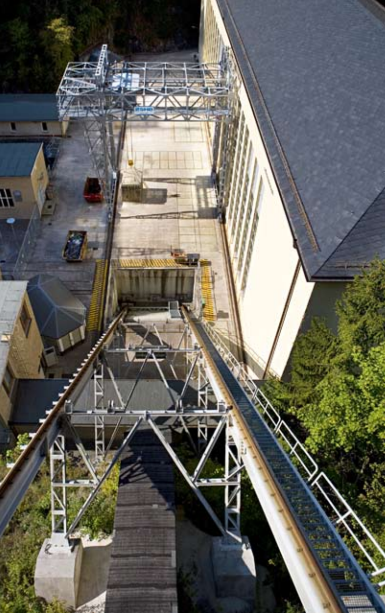
Bleiloch抽水蓄能电站对起重机的现代化改造，减少了维护，操作对用户更加友好。运行车间的两台起重机，与节流阀前岸的一台门式起重机衔接。这个方案的载重能力为100吨。
