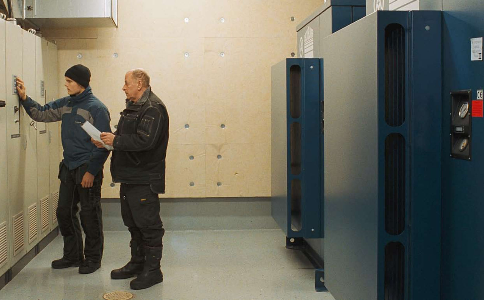
Emotron FDU frekvensomriktare styr blåsmaskiner och pumpar i Elmo Leathers nya reningsverk. - Det är första gången en helt biologisk reningsmetod används i garveriindustrin, berättar driftsingenjör Jan-Allan Hasselqvist (t h).
