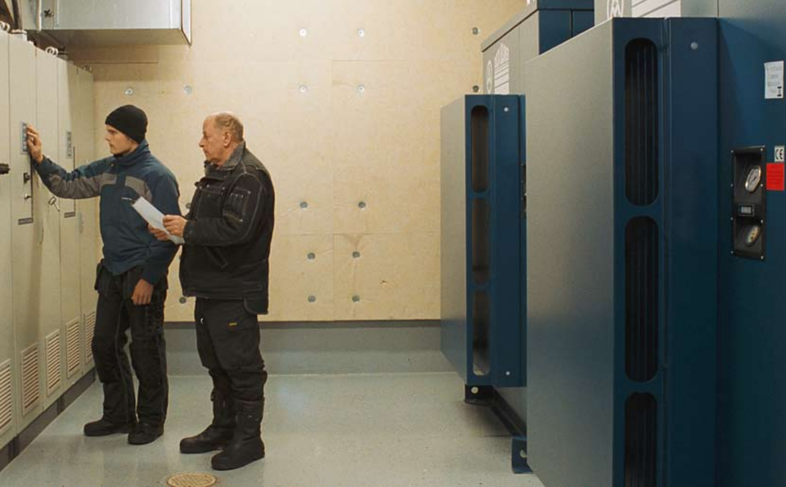
Bij de nieuwe afvalwaterzuiveringsinstallatie van Elmo Leather regelen Emotron FDU frequentieregelaars de blowers en pompen. "Dit is de eerste keer dat een volledig biologische zuiveringsmethode wordt toegepast in de looi-industrie," verklaart onderhoudsmonteur Jan Allan Hasselqvist (rechts).
