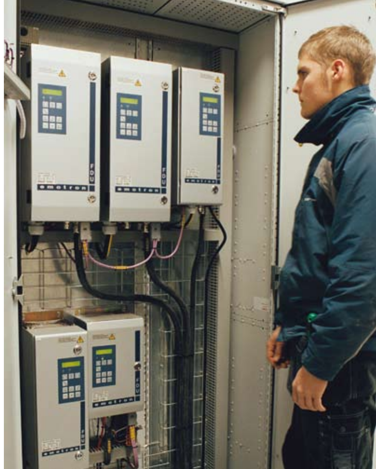
De elf FDU frequentieregelaars van Emotron van de installatie zijn in een elektronica-ruimte geïnstalleerd. Volgens bedieningstechnicus Oskar Österling vergemakkelijkt dit de bediening en bewaking.
