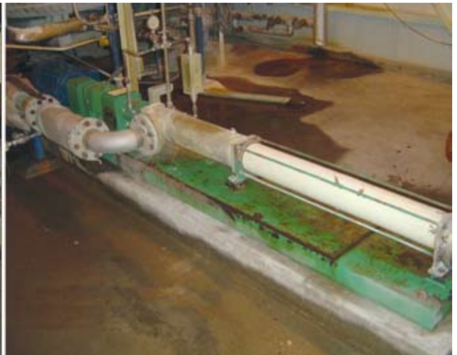
Emotron M20 axeleffektvakter skyddar progressiva kavitetpumpar (till vänster) och magnetdrivna centrifugalpumpar i ISP Chemicals anläggning i Calvert City.
