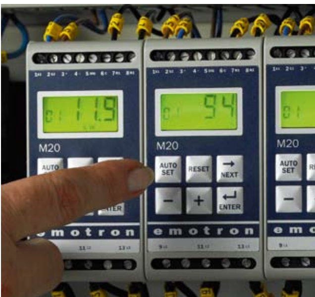
Emotron M20 har en unik automatisk inställningsfunktion som gör det möjligt att upprätta fyra gränsvärden på tre sekunder med en enda knapptryckning.
