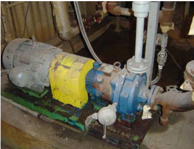
Emotron M20 axeleffektvakter skyddar progressiva kavitetpumpar (till vänster) och magnetdrivna centrifugalpumpar i ISP Chemicals anläggning i Calvert City.
