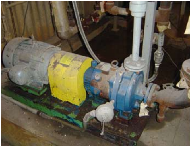
Die Emotron M20 Belastungssensoren schützen fortschrittliche Saugpumpen (links) und Magnetkreispumpen, wie sie in der Chemieanlage ISP Calvert City eingesetzt werden.
