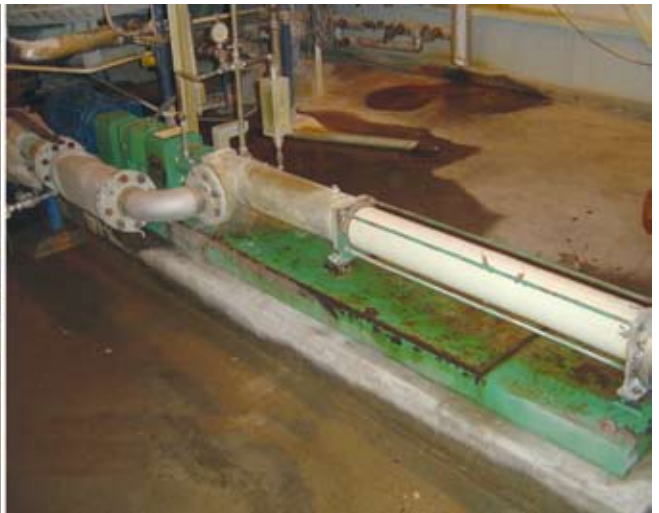
Los limitadores de par electrónicos Emotron M20 protegen las bombas de tornillo excéntrico (a la izquierda) y las bombas centrífugas magnéticas de la fábrica Calvert City de ISP.
