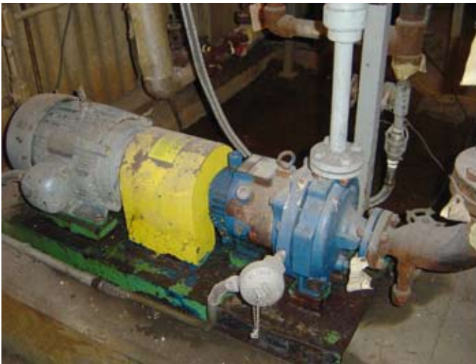
Emotron M20轴功率监视器保护ISP公司位于卡尔维特市化工厂的螺杆泵（左图）和磁力离心泵。
