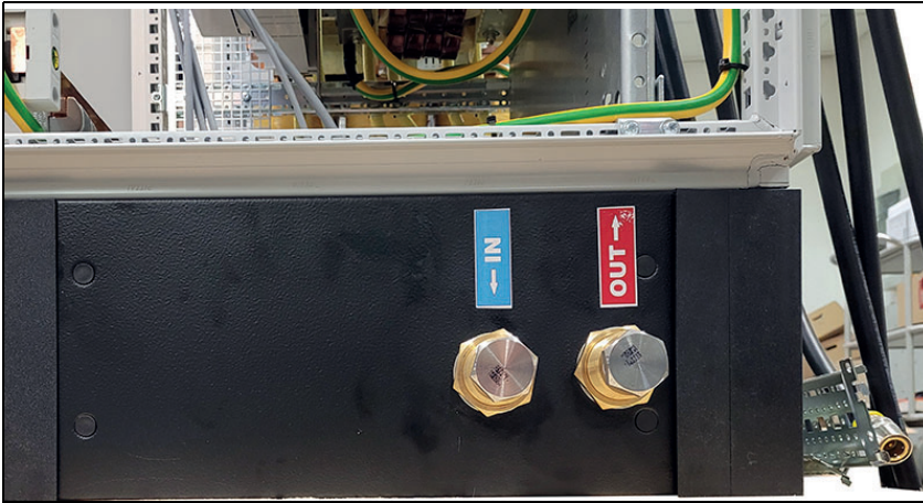
Fig. 19 Conexiones para el agua.
